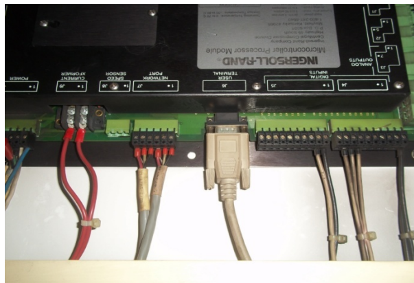
Gambar 2. Pemeriksaan pemasangan line kabel Basic Control Module kompresor
