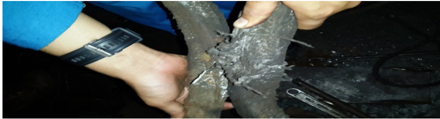
Gambar 5. Galnd Packing yang Rusak Proses Perbaikan
