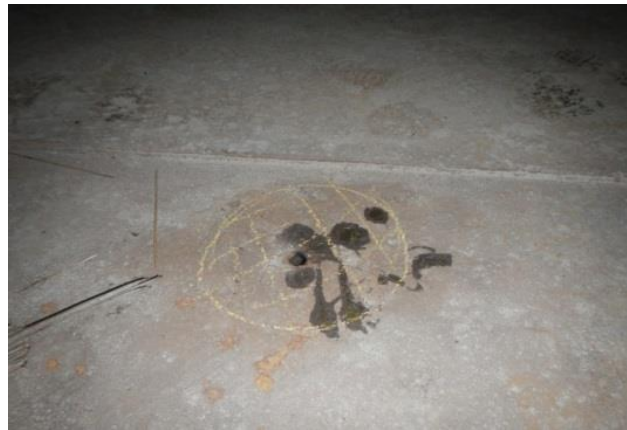
Gambar 3.1 Hasil Visual Test dan Pitting corrosion
