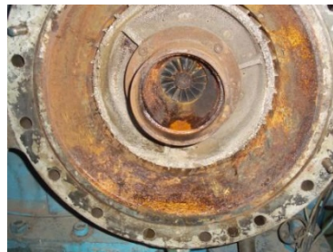
Gambar 3. Kondisi 2 nd stage yang korosi
